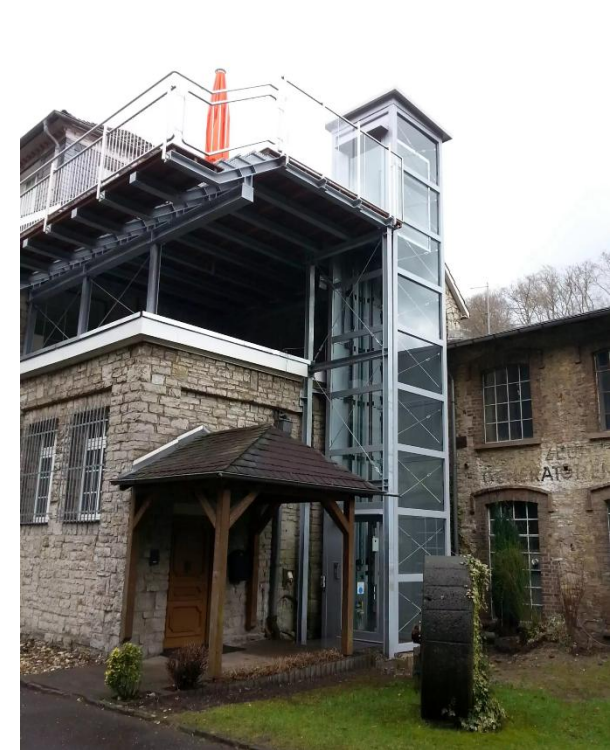
Abb.: Bsp. Anbau Personenaufzug © perfekta-lift
